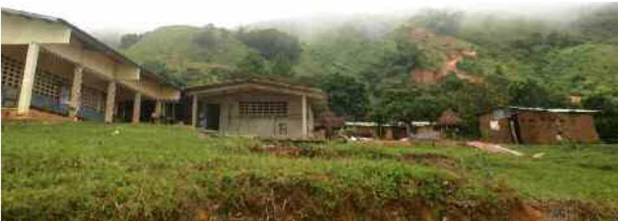
Alto Tólica: neues Schulgebäude (links), Kindergarten (im Bau), altes Schulgebäude (rechts, aus Lehm)
