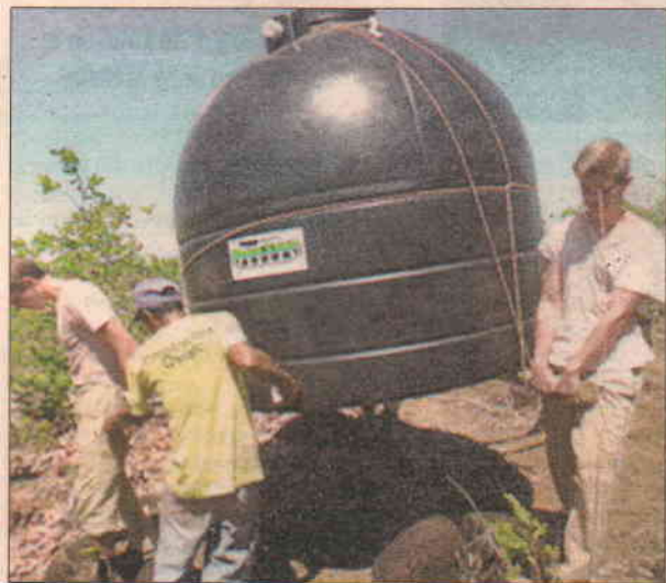
TRABAJAN. En la construcción de un acueducto comunitario en Caña Brava.
